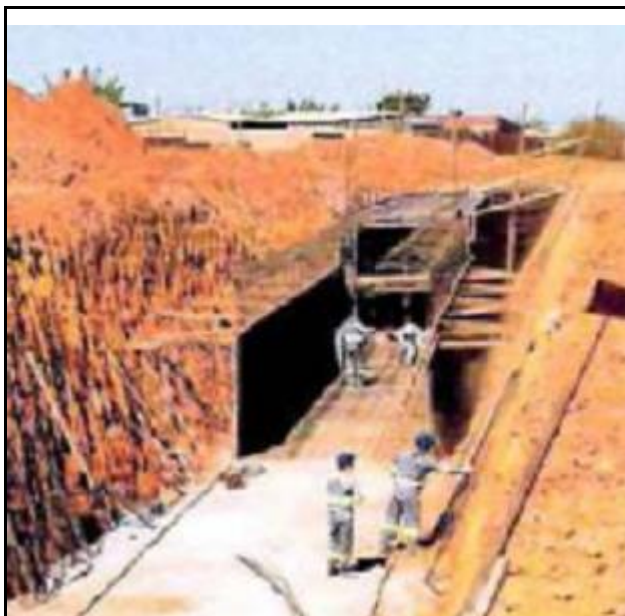
Foto 3: Tunnel liner de travessia sob a rede 14 e galeria celular de concreto
