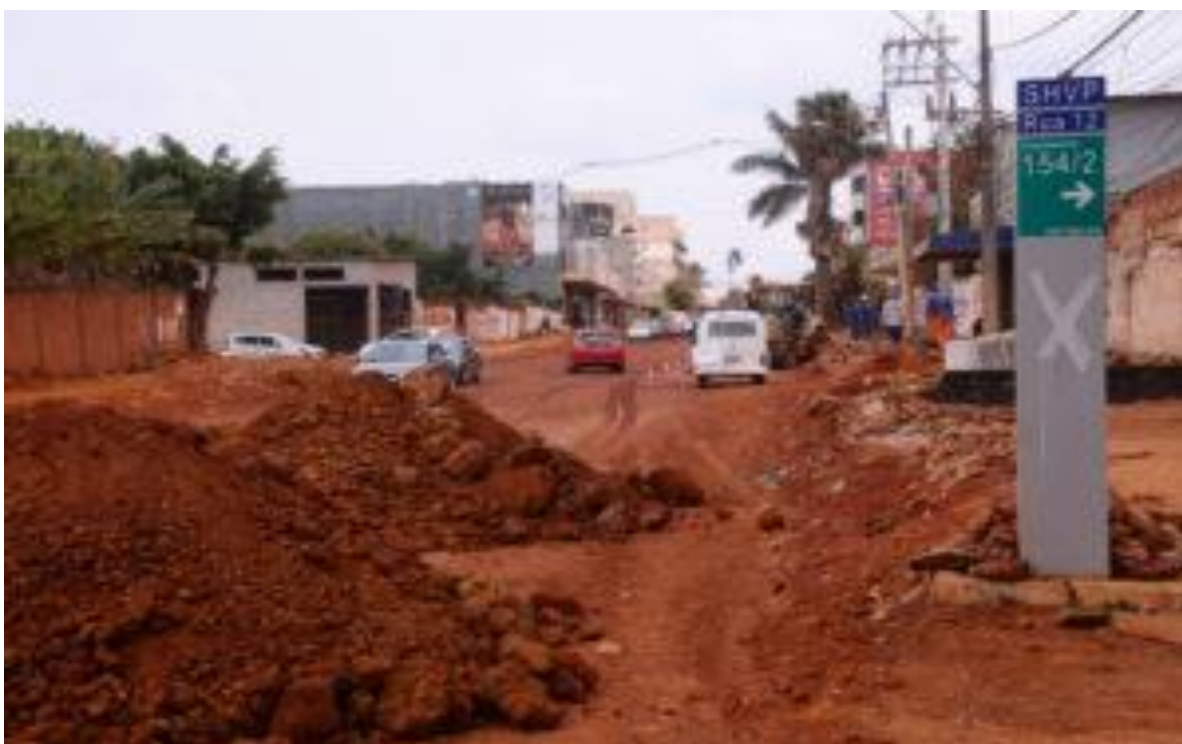
Rua 12 – Obras de drenagem e terraplanagem em andamento da Chácara 184/1 à 301. A previsão é de que os serviços nesta localidade sejam finalizados neste ano. A conclusão dos serviços de drenagem e pavimentação na via toda somente em 2020.
