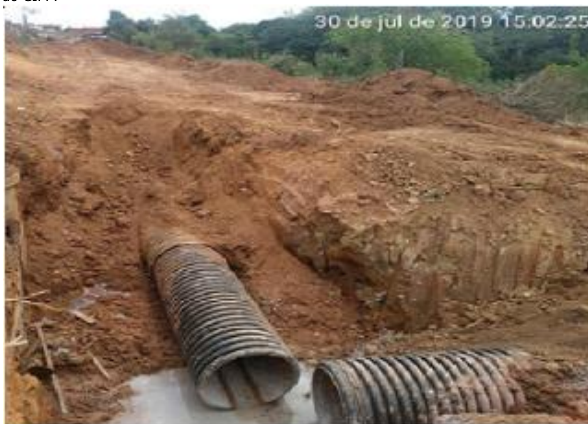
Implantação de tubo PEAD corrugado.
