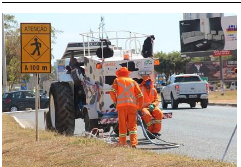
Foto 2: Pintura mecanizada de meios-fios
