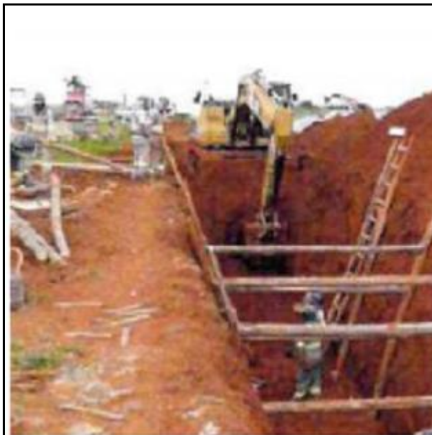
Foto 1: Execução de redes de drenagem pluvial
