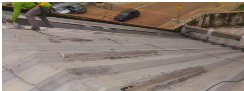
Figura 11 - Impermelização das telhas e dos rufos
