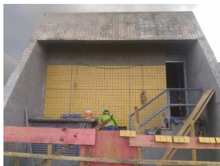
Figura 13 - Substituição de pastilhas
