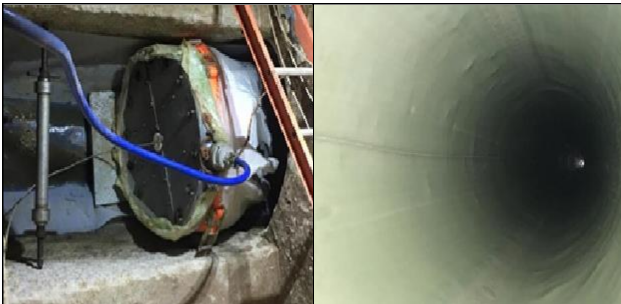
Tubo existente sendo recuperado com instalação do tecido de poliéster resinado com a Técnica do CIPP.
